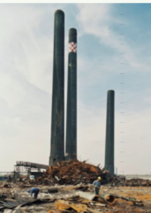
1993 stehen im Rahmen der Sanierungsarbeiten nur noch drei Türme des ehemaligen VEB Chemiekombinates Bitterfeld. Nach den Räumungsarbeiten kann die Bodensanierung starten.
